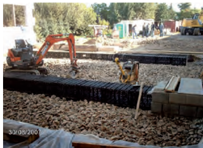
Abb. 15: Bau eines luftdurchströmten Schotterspeichers
