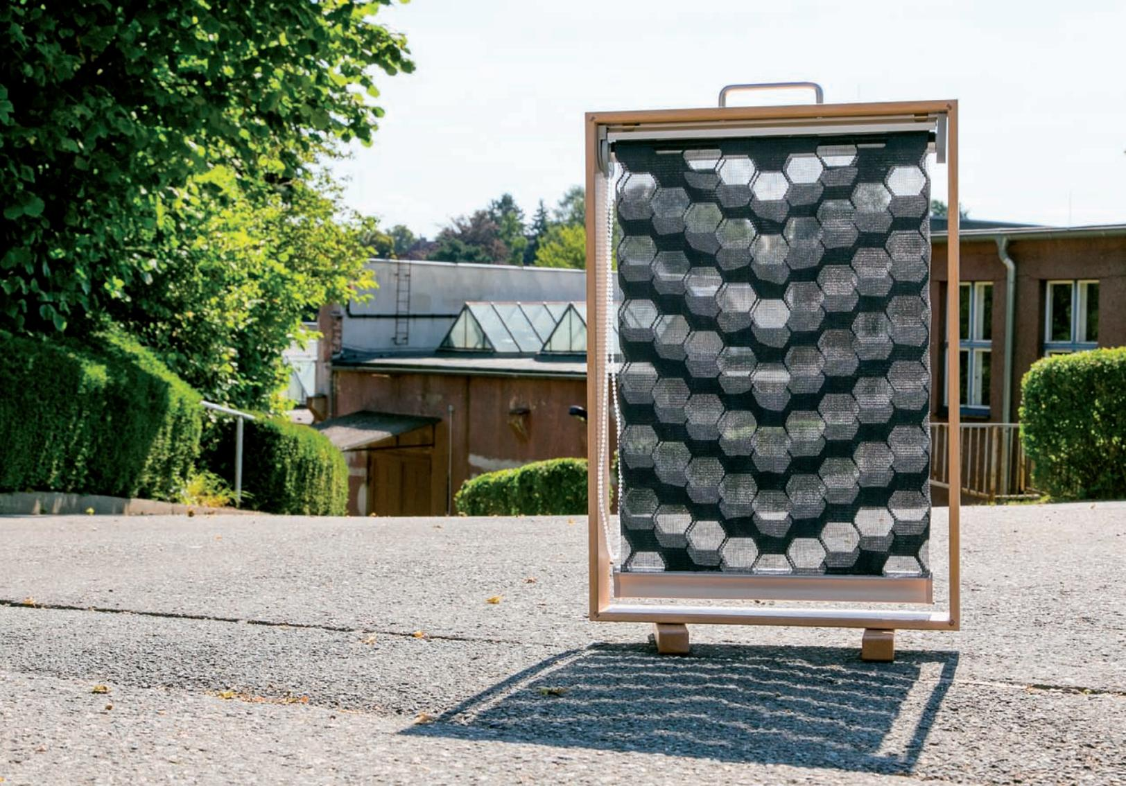
*Die Anordnung der Verschattungselemente ermöglicht die Erzeugung von geschlossenen Strukturen und liefert komplett blickdichte Flächen. Bei einer anderen Positionierung der Elemente zueinander, entstehen offene Muster, die den Lichtdurchlass regulieren. Aus den unterschiedlichen Anordnungen ergibt sich eine variable und vielseitige Gebäudegrafik.*
